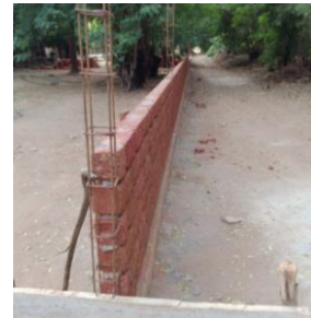
Début de construction du mur d'enceinte
